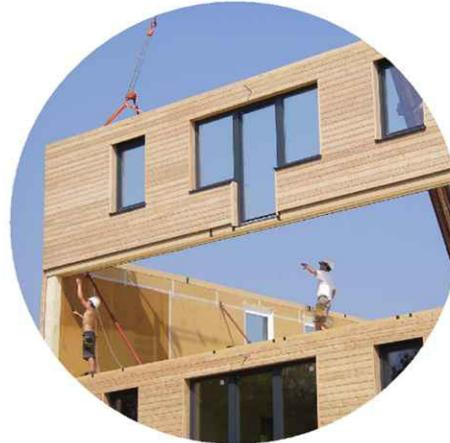
Die Fassadenfläche wird anhand der tragenden Wände in einzelne geschosshohe Module untergliedert. Diese werden werkseitig komplett vorgefertigt und auf der Baustelle an die Stirnseiten der tragenden Wände und Geschossdecken montiert.
