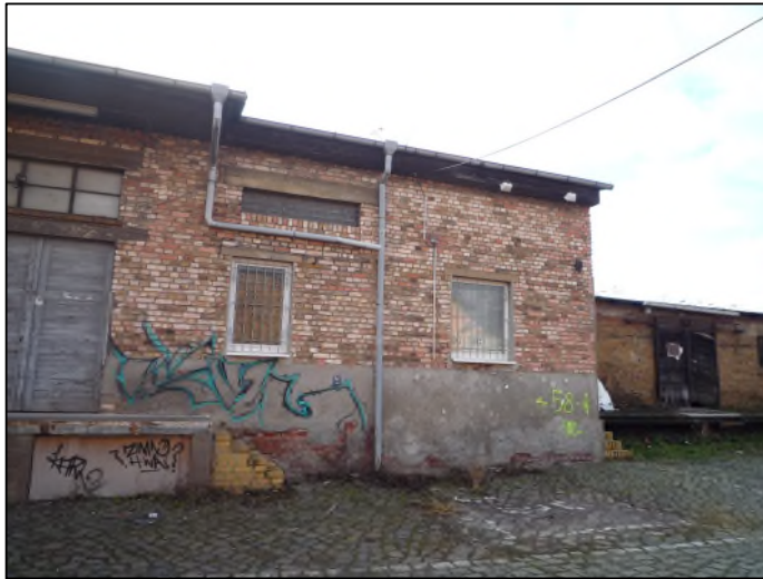
Abbildung 8: Regenfallrohr an Bestandsgebäude
