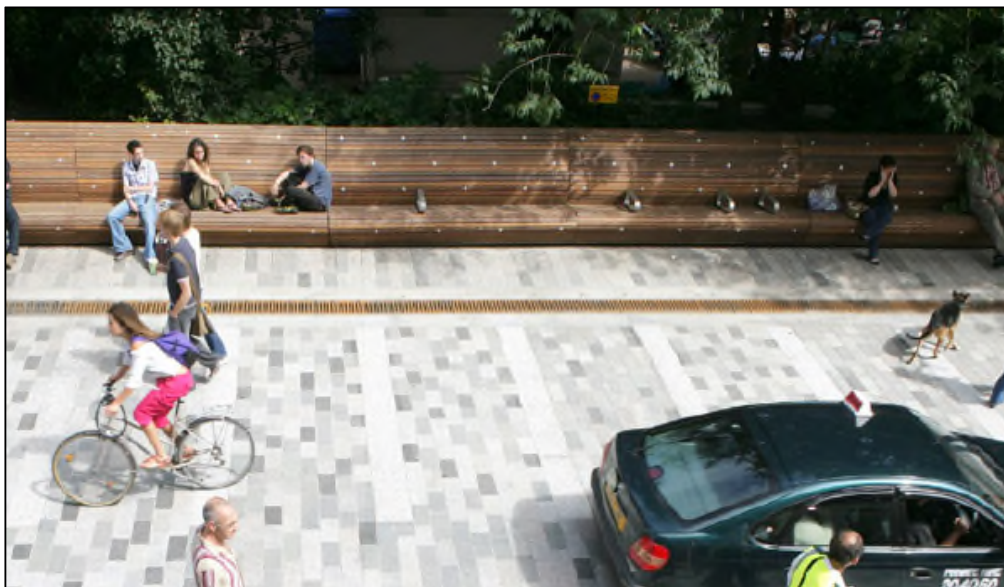
Abbildung 15: Entwässerungsrinne in Wohnstraße (Quelle: Strassentypologien Loidl)
