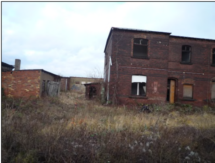
Abbildung 3: Ungenutzte Gebäude im Plangebiet
