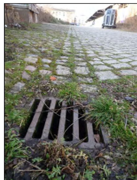
Abbildung 6: Straßeneinlauf im Plangebiet
