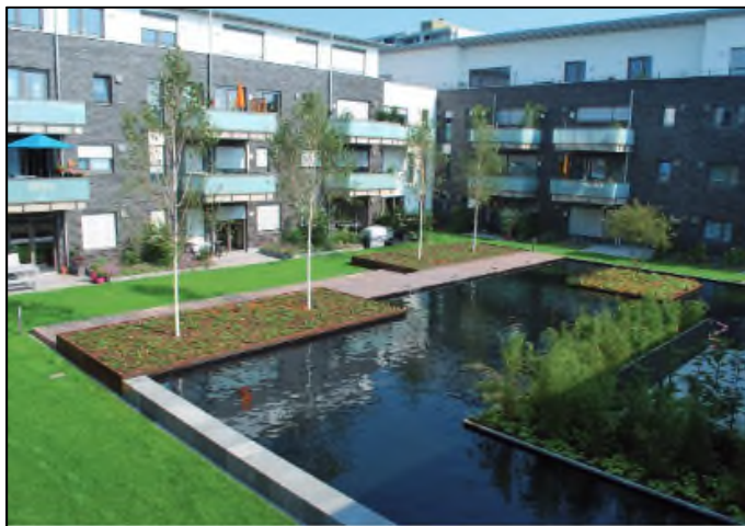
Abbildung 48: Wasserspeicher in Innenhof (Quelle: Optigrün)
